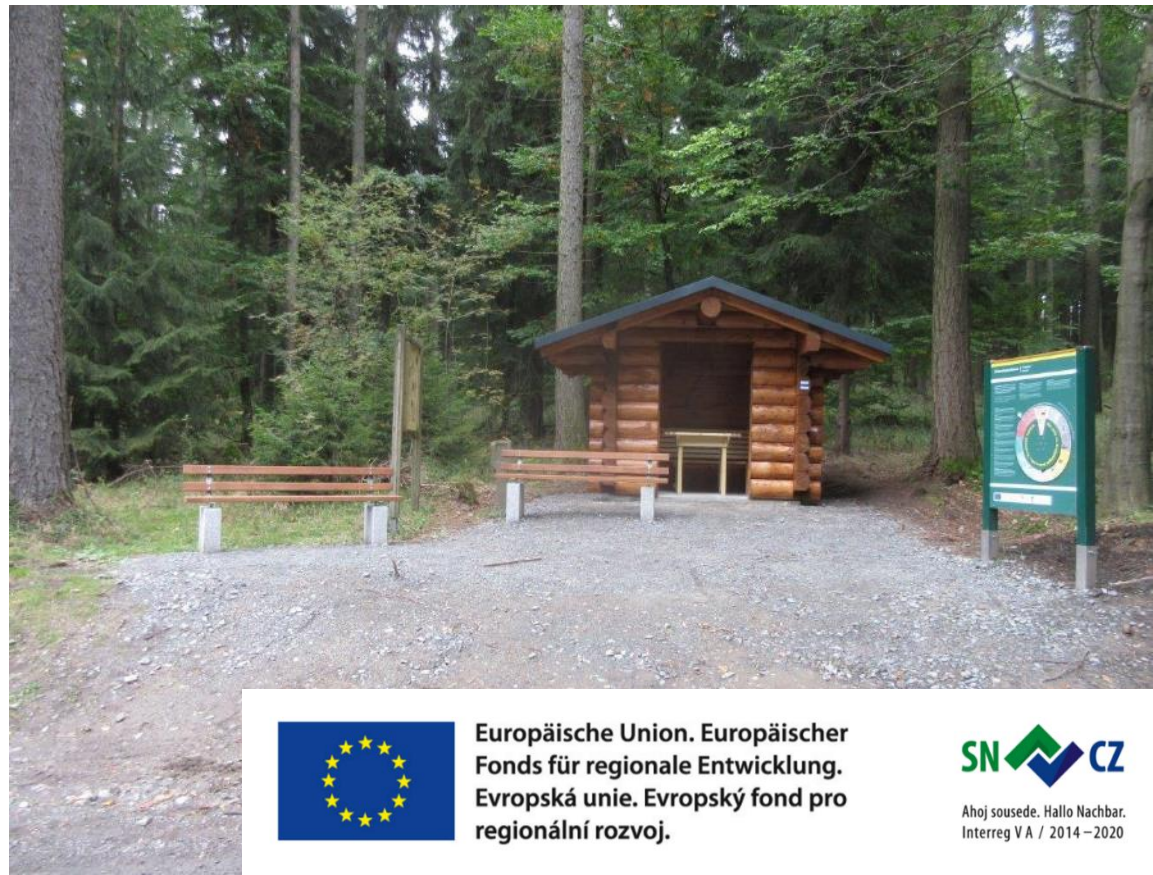
Schutzhütte an der Station 2 • Přístřešek na 2. zastavení
